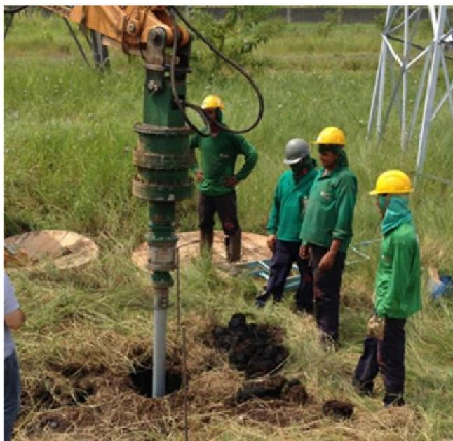
Figura 9 - Motor hidráulico para instalação da estaca
