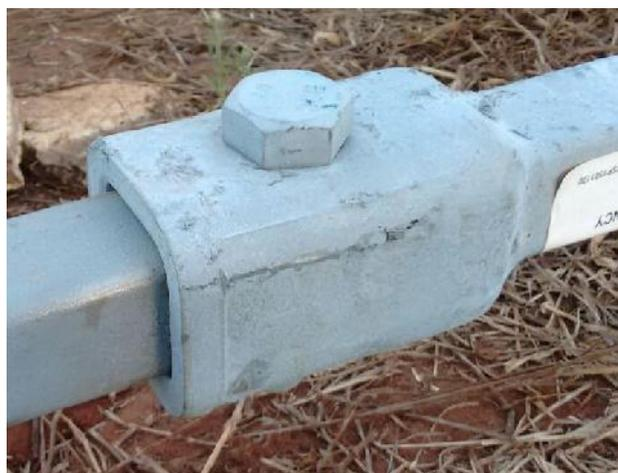
Figura 10 - Emenda das estacas com eixo maciço
