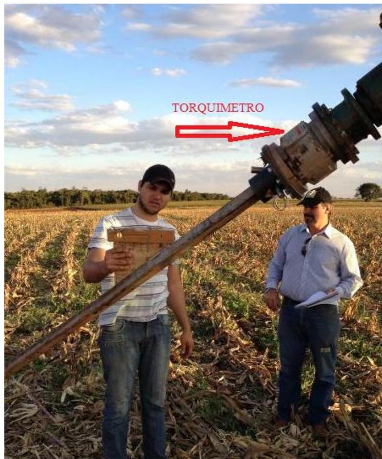
Figura 24 – Procedimento de instalação da estaca helicoidal
