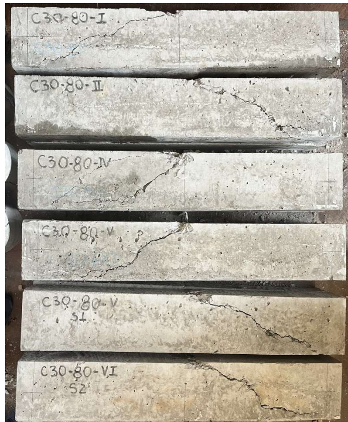
Figura 57 - Aspecto final das vigas do grupo C30-80 após ensaio
