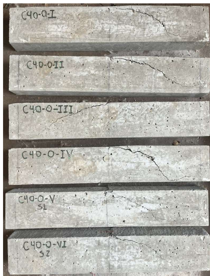
Figura 67 - Aspecto final das vigas do grupo C40-0 após ensaio
