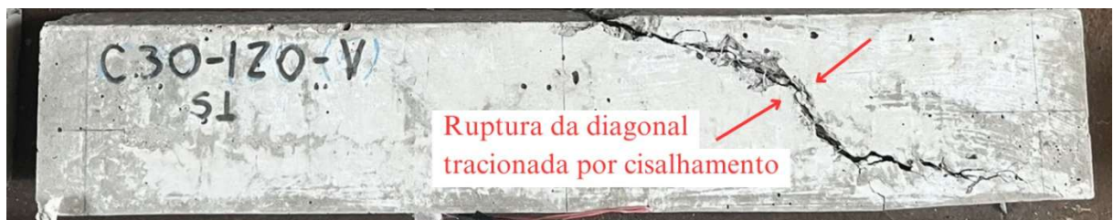
Figura 62 - Panorama de fissuração do grupo C30-120
