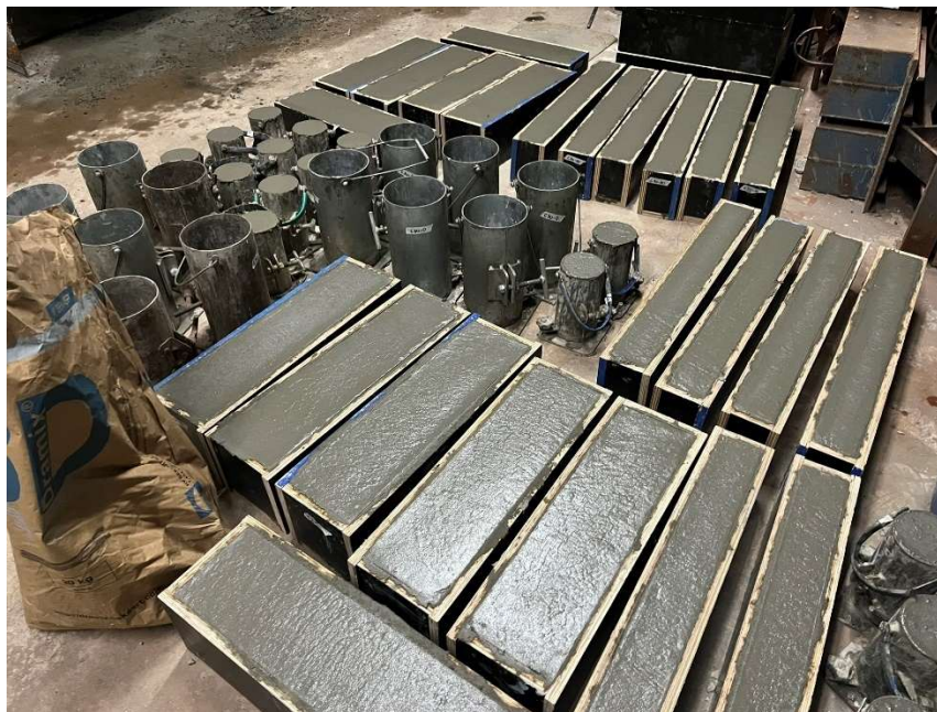
Figura 17 - Concretagem dos Corpos de Prova e Vigas
