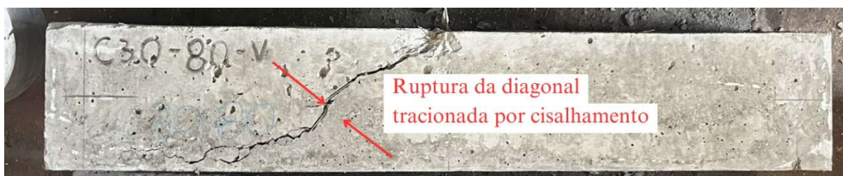
Figura 56 - Panorama de fissuração do grupo C30-80
