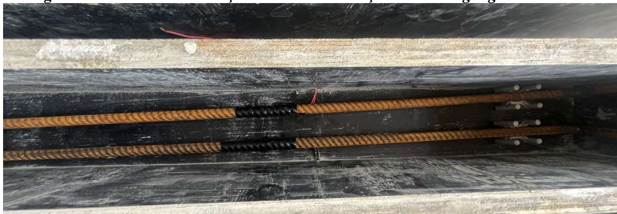
Figura 26 – Detalhe da Locação das Barras de Aço com strain gauges nas Formas
