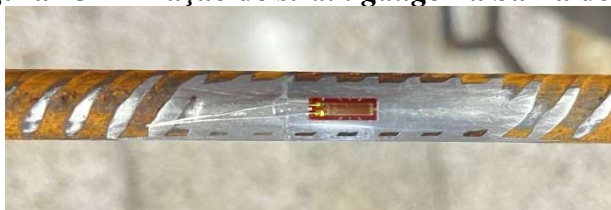
Figura 25 – Fixação do strain gauge na barra de aço
