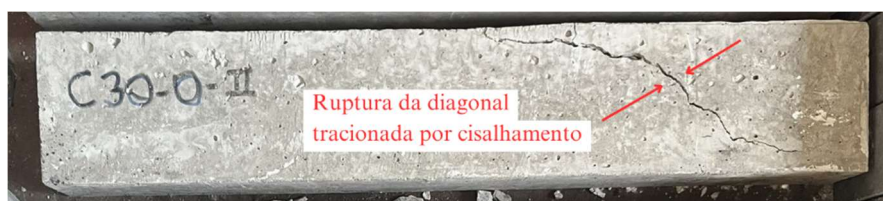
Figura 53 – Panorama de fissuração do grupo C30-0
